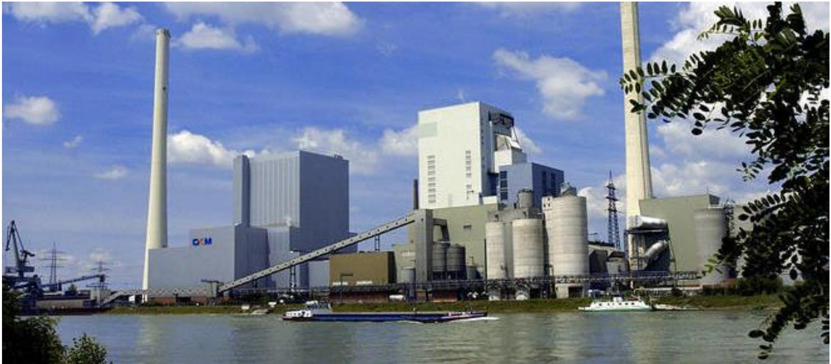
**Der Block 9 des GKM ging 2015 als eines der modernsten Kohlekraftwerke der Welt ans Netz. Dampfdaten für Dampfturbinen: 290 bar, 600°C; Industriedampf: 20bar; Elektrische Leistung: 900 MW, davon 350 MW für die Deutsche Bahn DB; Elektrischer Wirkungsgrad: 46.4%, mit Kraft-Wärme-Koppelung: 70%. Vier Speicherlokomotiven, die mit Dampf von 20 bar geladen werden, ziehen Kohlenzüge von bis zu 4'000 t ins Werk.**
