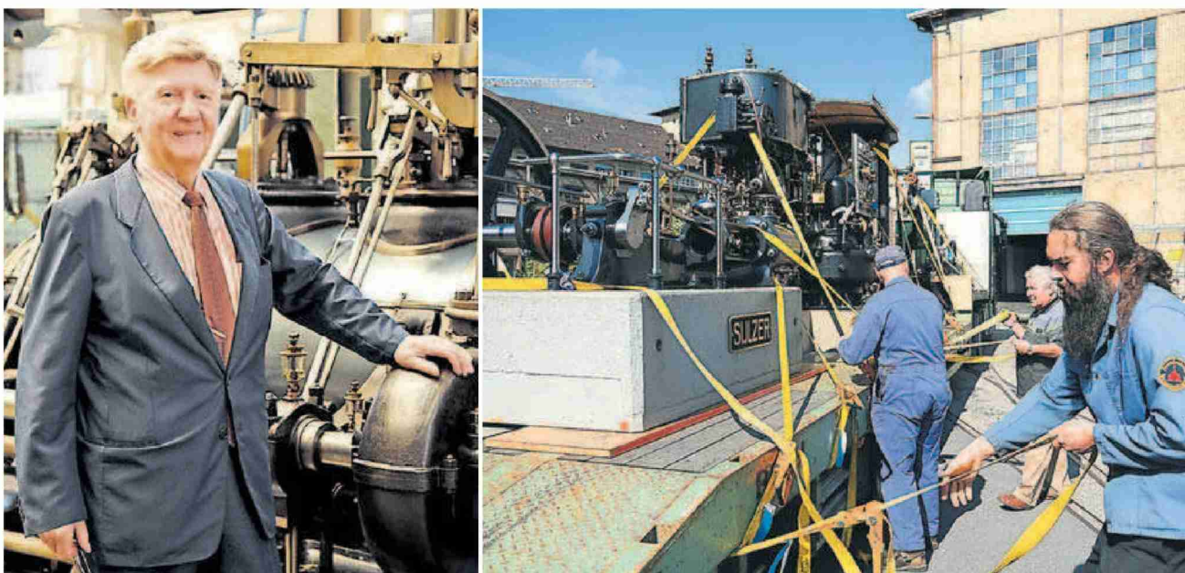
Robert Heuberger vor einer Sulzer-Dampfmaschine aus dem Jahr 1901, mit der Strom für die Basler Trams erzeugt wurde. Er ermöglichte es, dass die alten Maschinen dieser Tage wieder in Winterthur ankommen. Bilder: Marc Dahinden
